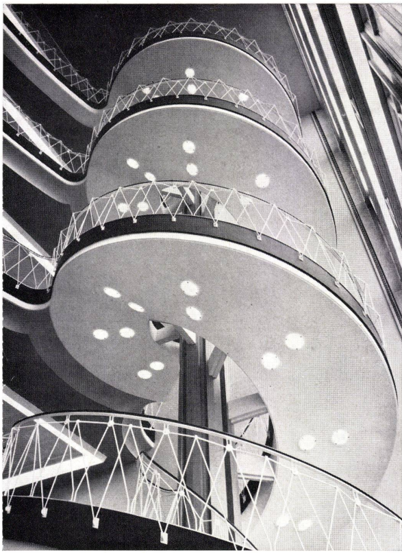
Treppenhaus Verwaltungsgebäude Gebr. Sulzer AG in Winterthur. — Arch. Suter & Suter, Basel
