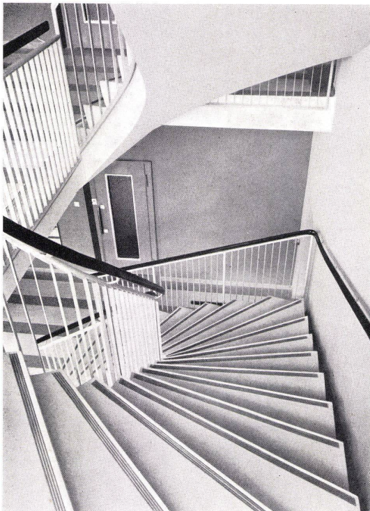
Effingerhaus in Bern Volltritte mit Gleitschutzeinlage auf Betonrampe versetzt
