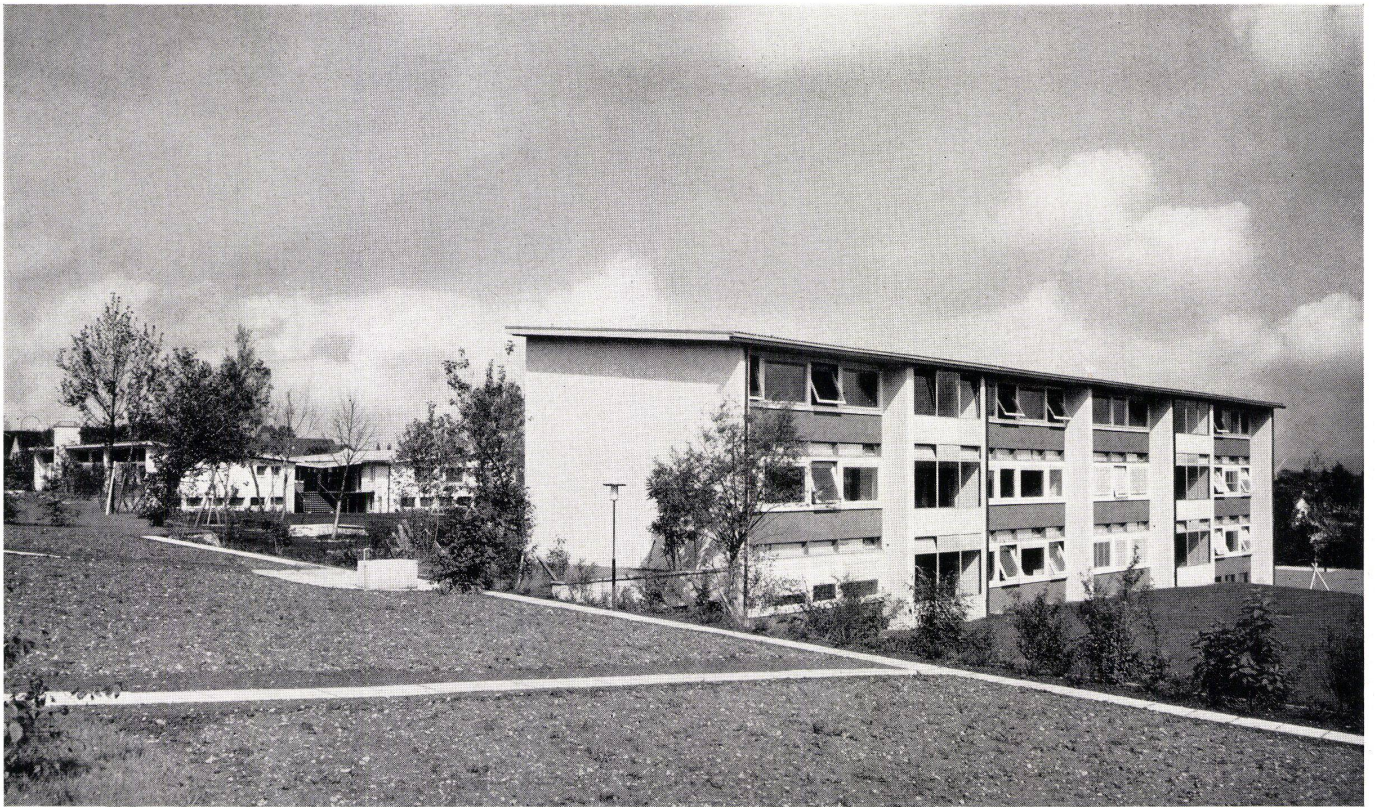
Klassentrakt von Süden, im Hintergrund Spezial- und Turnhallentrakt.
