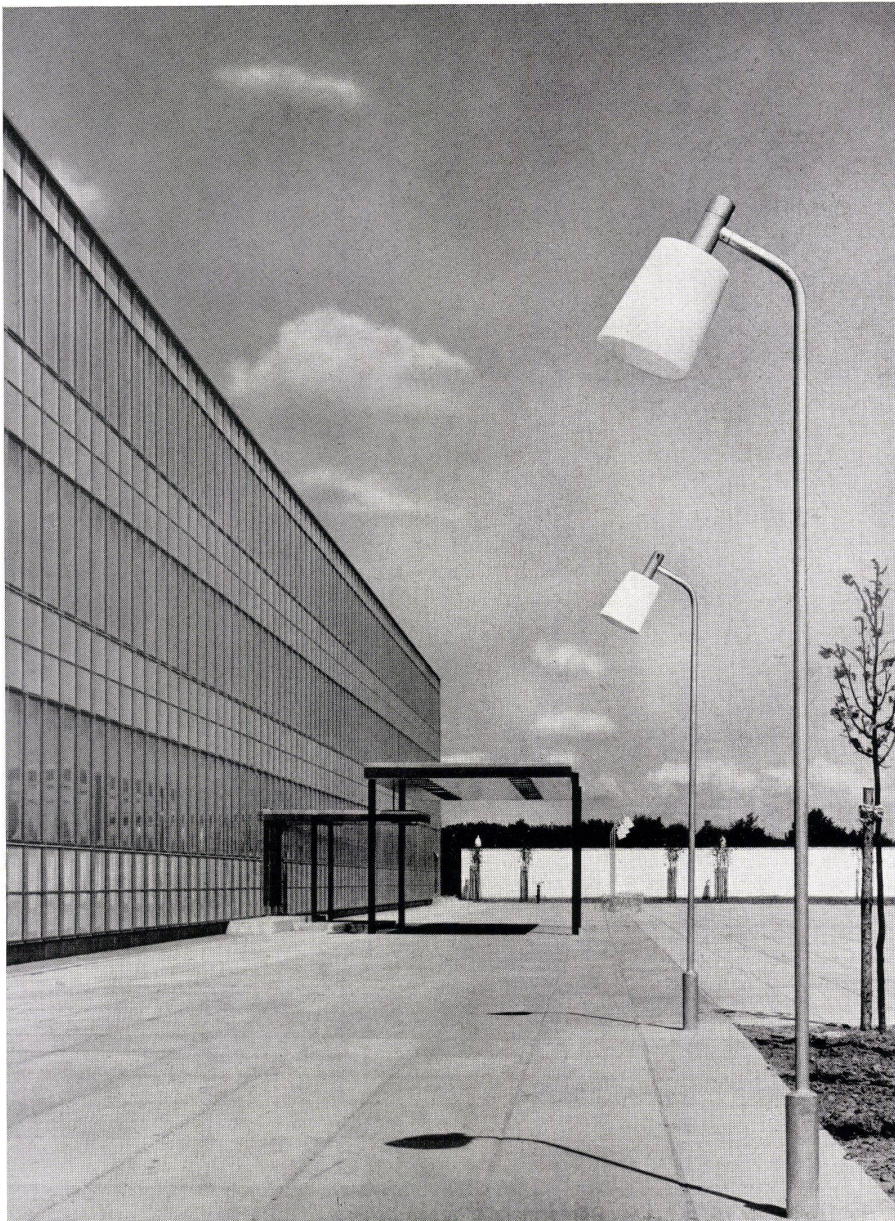
Eingangshof und Haupteingang. Cour d'entrée et entrée principale. Entrance court and main entrance.
