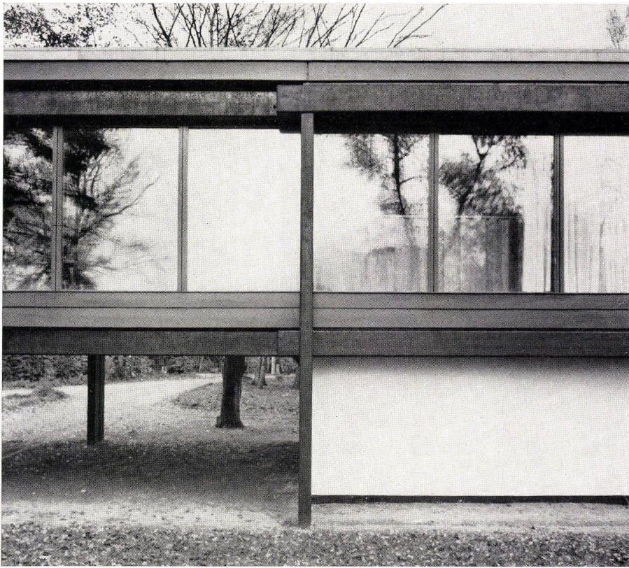
Detail der Westwand. Détail de la paroi ouest. Detail of west partition.
