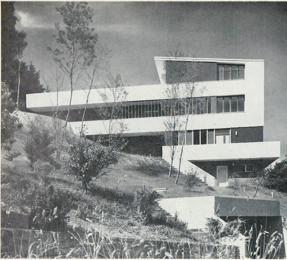
1 Ansicht von Norden. Vorn Garage; im Haus zuunterst die 2-Zimmer-Wohnung, darüber mit dem großen Balkon die 4½-Zimmer-Wohnung, zuoberst das Einfamilienhaus.
