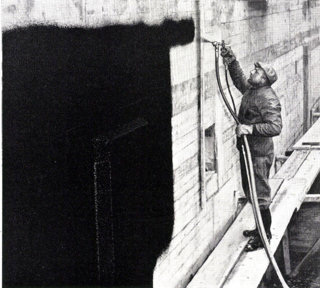
Fundamentabdichtung am neuen Verwaltungsgebäude des Elektrizitätswerkes Winterthur
