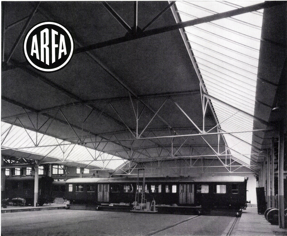
SBB Reparaturwerkstätte Olten, Binderkonstruktion ausgeführt mit ARFA Konstruktionsrohren durch Geilinger & Co., Winterthur.
