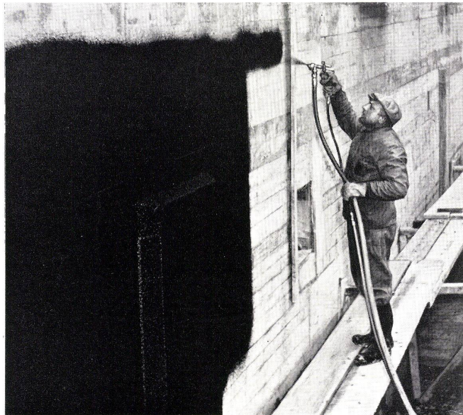
Fundamentabdichtung am neuen Verwaltungsgebäude des Elektrizitätswerkes Winterthur
