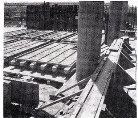
Die Deckenelemente werden am Boden zusammengesetzt und mit Heißdampf innert kürzester Zeit erhärtet. Les éléments de plafonds sont assemblés au sol et durcis en très peu de temps à la vapeur à haute température. The ceiling elements are assembled on the ground and hardened in a very short time by live steam.
