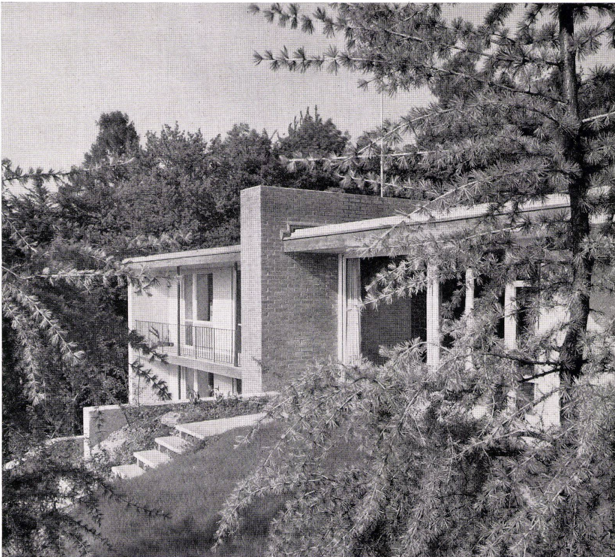
Blick von Süden auf den Gartenausgang am Wohnzimmer und den Schlaftrakt mit Südwestbalkon. L'entrée du jardin et l'aile des chambres avec le balcon vus du côté sud. Garden exit near the living-room and bedroom wing with balcony as seen from the south.
