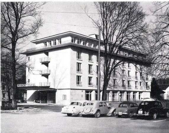
Sulzer-Klimakonvektoren im Gartenhotel Winterthur
