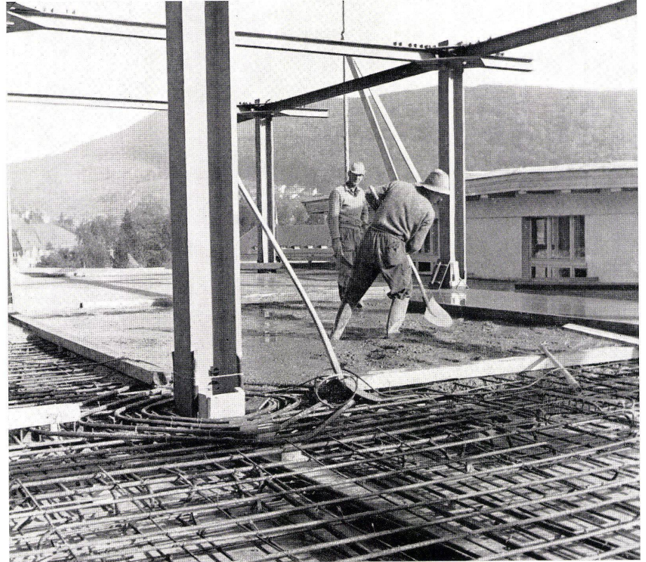
3 Deckenarmierung. Armure du plafond. Ceiling reinforcement.
