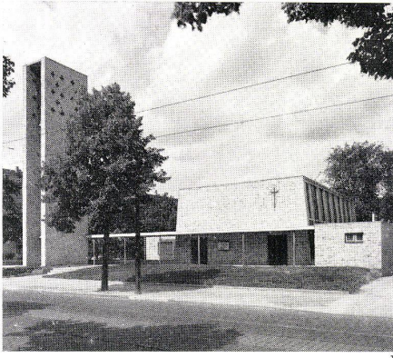
1 Michaelskirche in Berlin-Schöneberg. Links Glockenträger, rechts Sakristei, Mitte Kirchenschiff, im Hintergrund links das Gemeindehaus. Architekt: Günther Kohlhaus.
