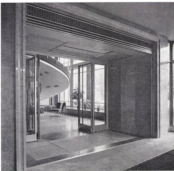
Luftvorhang in vollständig klimatisiertem Bürogebäude
