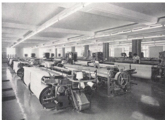
Klimaanlage in einem Textilbetrieb
