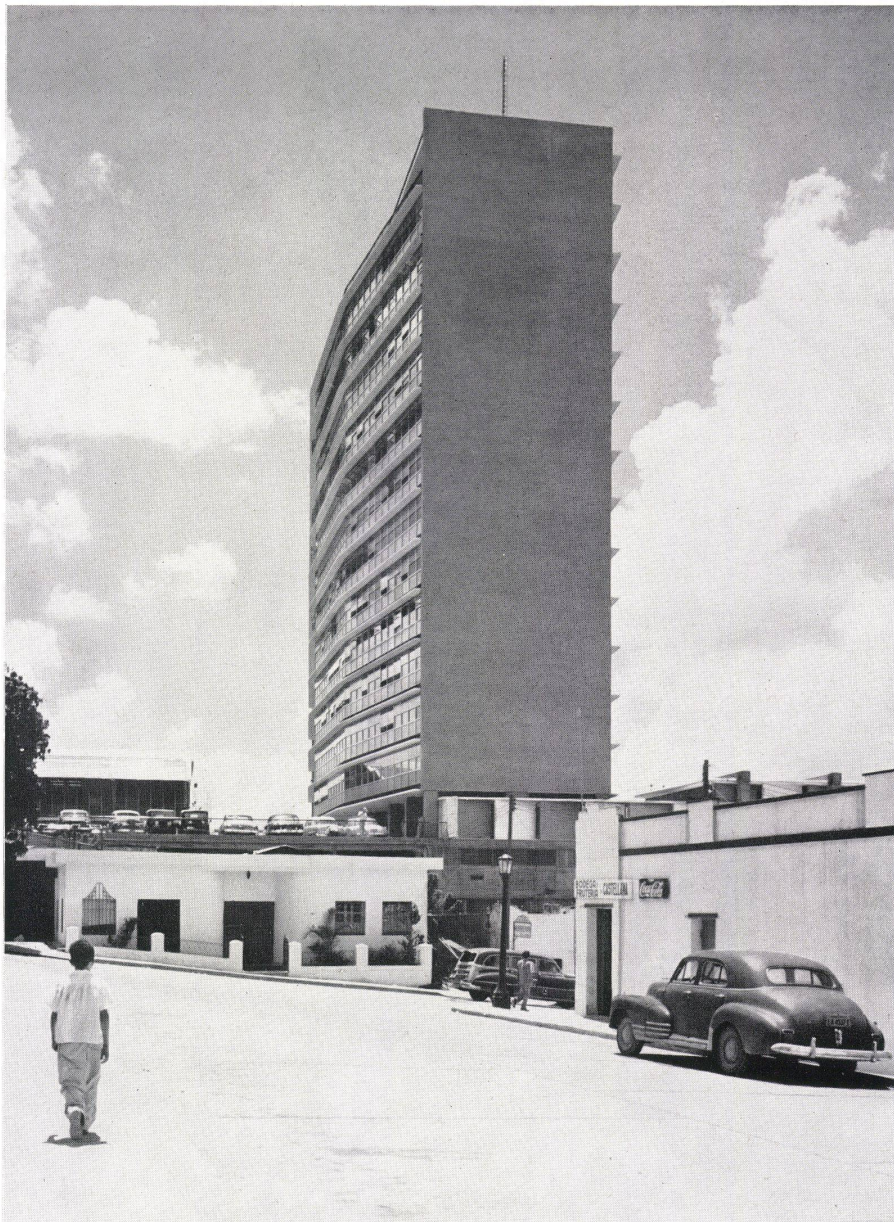
Blick auf das Bürohochhaus von Osten. Vue de l'est de l'immeuble-tour commercial. View of the office tower from the east.
