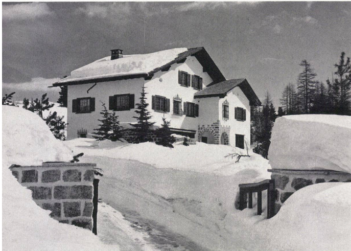
Landhaus im Engadin mit Sulzer-Zentralheizung
