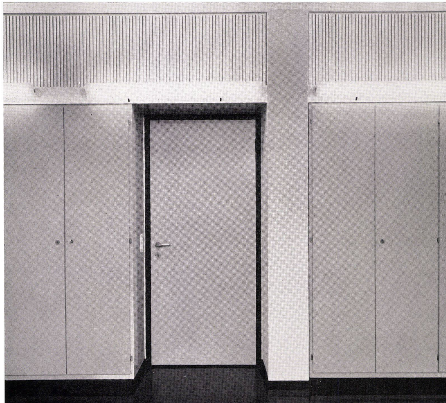
3+4 Details von Korridorwänden mit Einbauschränken. Détails du corridor à placards encastrés. Details of corridor with cupboards.
