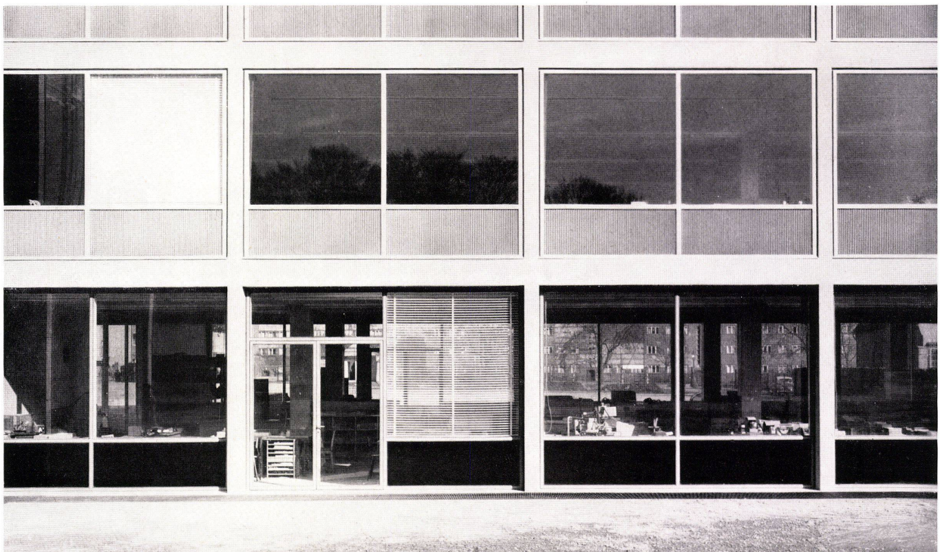
Fassadendetail. Schalungsrohes Stahlbetonskelett von größter Präzision der Ausführung (0,5 cm Toleranz). Weiß lackierte, 4 cm breite Holzrahmen, fest verglaste Scheiben. Blau emailliertes Wellblech als Brüstungsfüllung. Détail de la façade. Detail of elevation.
