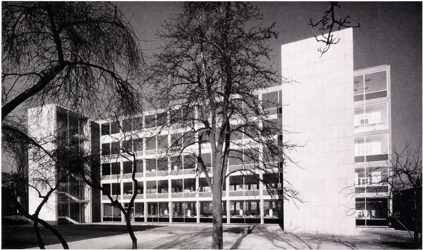
Gesamtansicht von Westen mit den völlig freistehenden Treppentürmen. Stirnwände der Treppentürme in geschliffenen Kunststeinplatten verkleidet. Vue d'ensemble de l'ouest. General view from the west.
