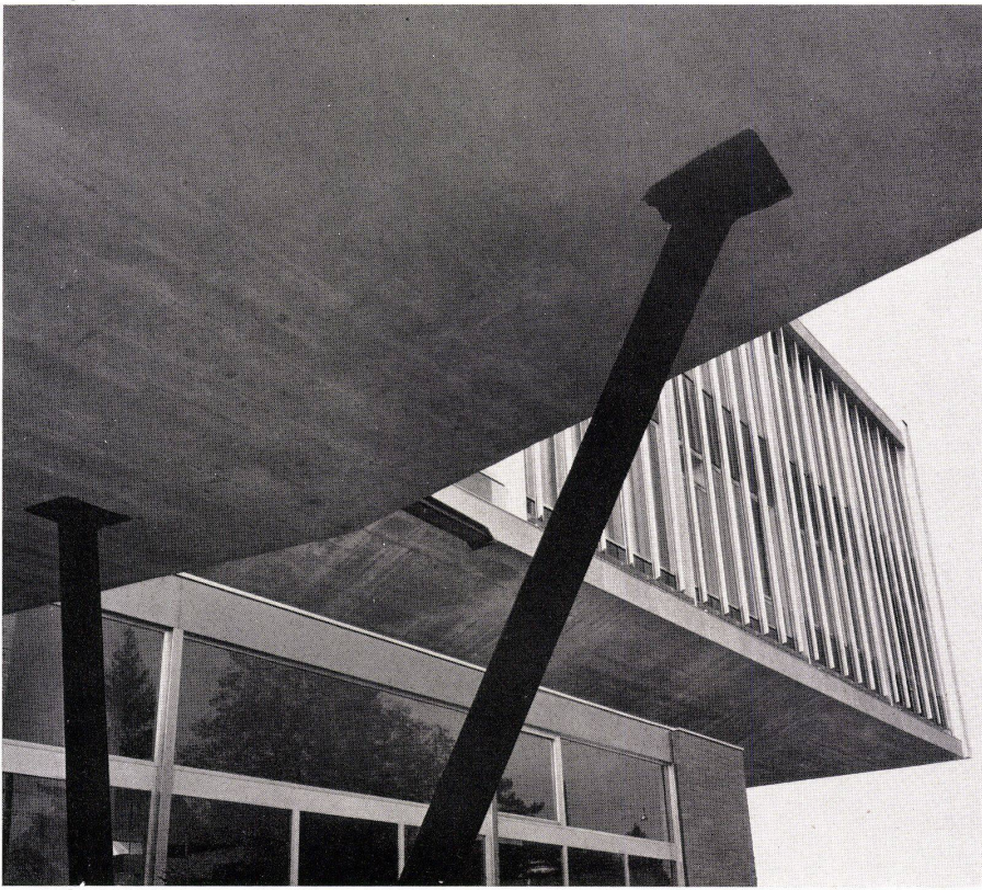
1 Blick vom überdeckten Eingang auf eine Gebäudeecke. Vue de l'entrée couverte vers un coin du bâtiment. View from the covered entrance to a corner of the building.
