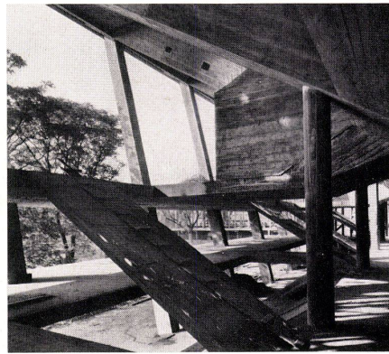
Dachhaut und die Stirnflächen der Haupthalle mit Aluminiumrollen aus »Fural« abgedeckt. Eine wichtige Rolle wurde der Akustik eingeräumt. Sowohl der polygonale Grundriß, als auch die durchhängende Decke der Haupthalle haben sich, nach bereits angestellten Berechnungen als Raumform mit akustisch optimalen Eigenschaften erwiesen. Auch in den Trainingshallen wurden Decken und Wände aus akustischen Erwägungen mit schallschluckenden Elementen verkleidet. Das in der Mitte durchhängende Dach und die geknickten Seitenwände aus Glasbausteinen dienen der Zerstreuung des Schalles, der erfahrungsmäßig in solchen Hallen sehr störend wirken kann.
