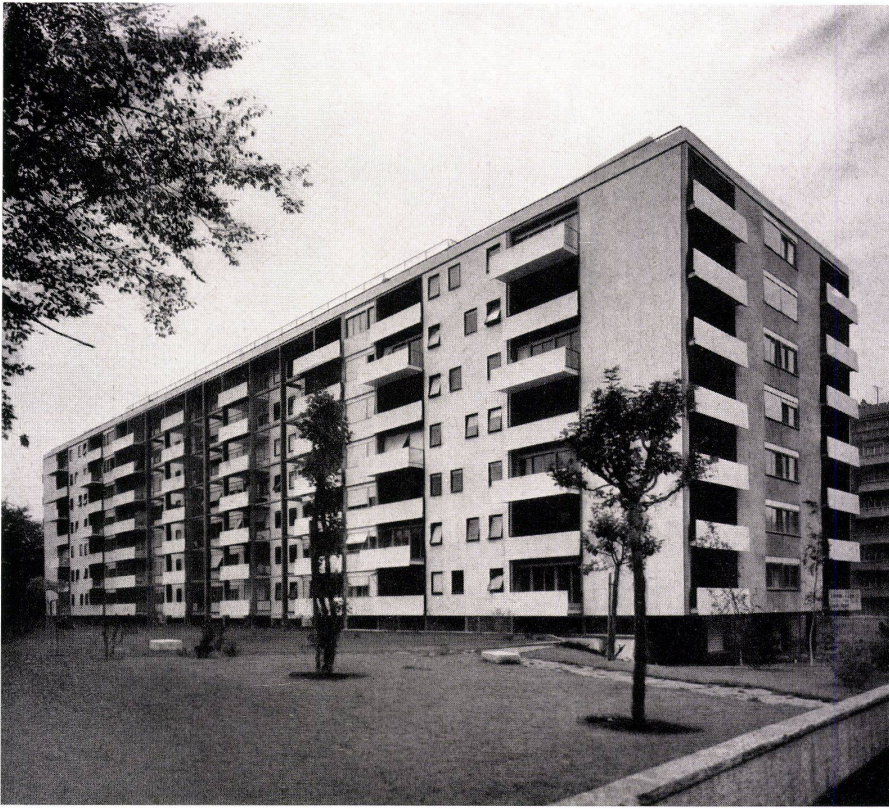
1 Ansicht von Osten mit Fußgängerzugang und Ventilationskaminen der Kellergarage. Vue de l'est avec l'entrée des piétons et les cheminées de ventilations du garage au sous-sol. View from east with pedestrian entrance and ventilation ducts on garages.
