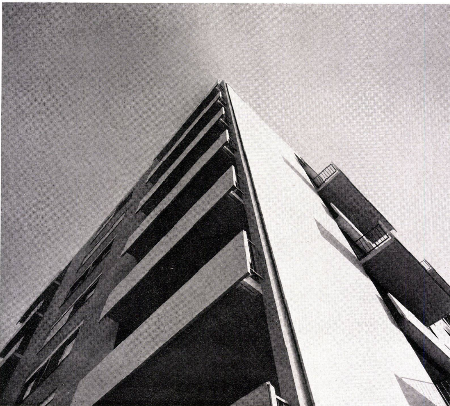
4 Eckendetail mit Balkonen. Vue d'un coin avec balcons. Corner detail with balconies.
