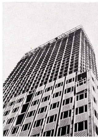
Die Aluminiumfassade eines modernen Büro-Wolkenkratzers
