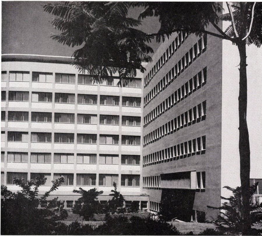
Blick in die Nordwest-Ecke des zweiten Hofes. Rechts die Fensterstreifen der Nebenräume in Behandlungstrakt. Vue du coin nord-ouest de la deuxième cour. A droite les rangées de fenêtres des annexes de la partie de traitement. Glimpse of north-west corner of courtyard. Right windows of utility rooms of medical section.
