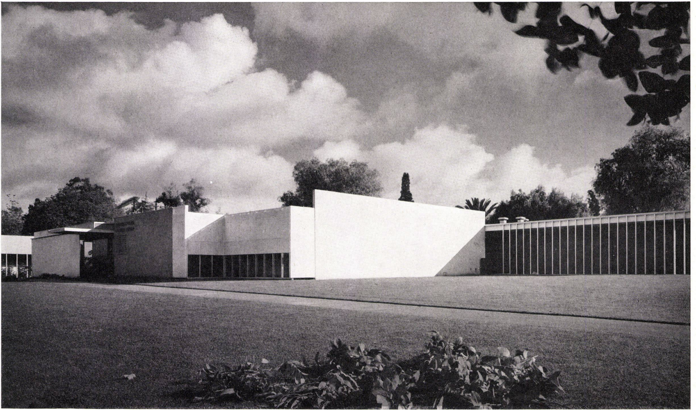
Ansicht von Westen, d. h. vom Parkplatz aus, auf die ganze Gebäudegruppe.
