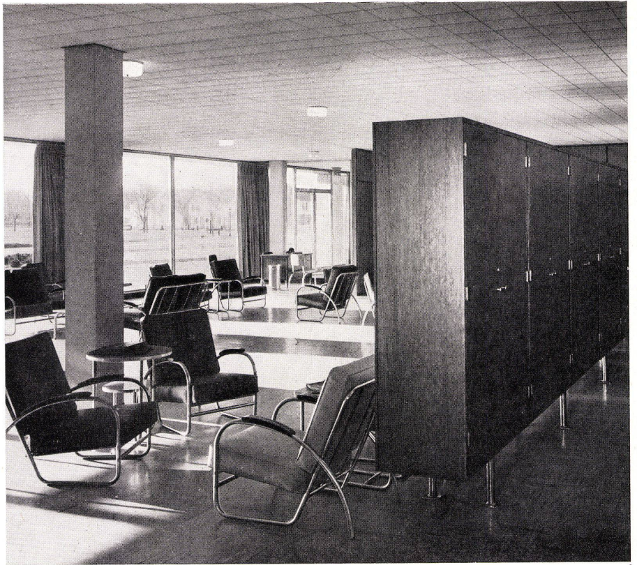
1 Anmelde- und Warteraum. Salle de réception et d'attente. Reception and waiting room.
