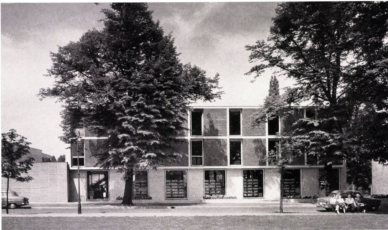
Bibliotheksgebäude von der Tesdorpfstraße aus. Bâtiment de la bibliothèque vu de la Tesdorpfstrasse. Library building from Tesdorpfstrasse.
