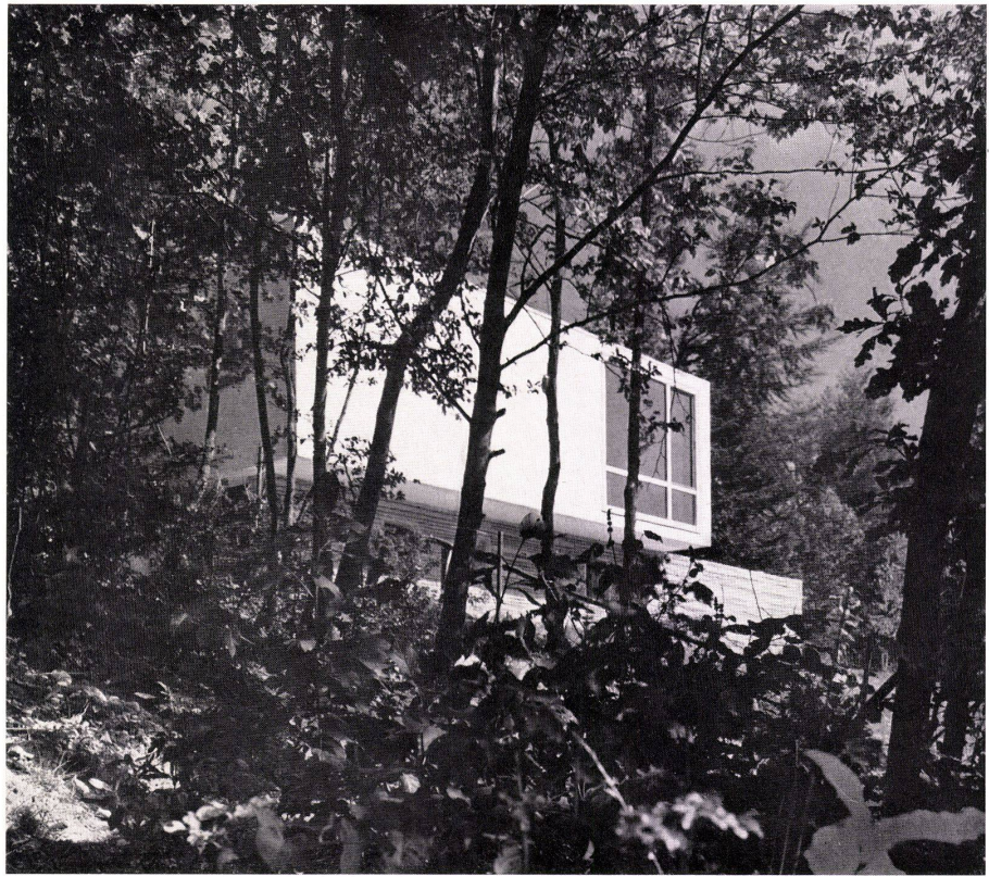
Südwestansicht und Blick in die Waldlichtung. Vue du sud-ouest et vue vers la clairière de forêt. View from south-west and view into forest clearing.
