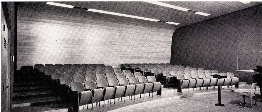
Übungsraum für den Chor mit 100 Sitzplätzen. Akustikdecke und Rückwand aus Birkenholz. Wände: perforierte Akustikplatten. Salle d'exercice du chœur avec 100 places assises. Plafond acoustique et paroi arrière en bouleau. Murs: panneaux acoustiques perforés. Practice room for the choir with 100 seats. Acoustic ceiling and rear wall of birch wood. Walls: perforated acoustic slabs.
