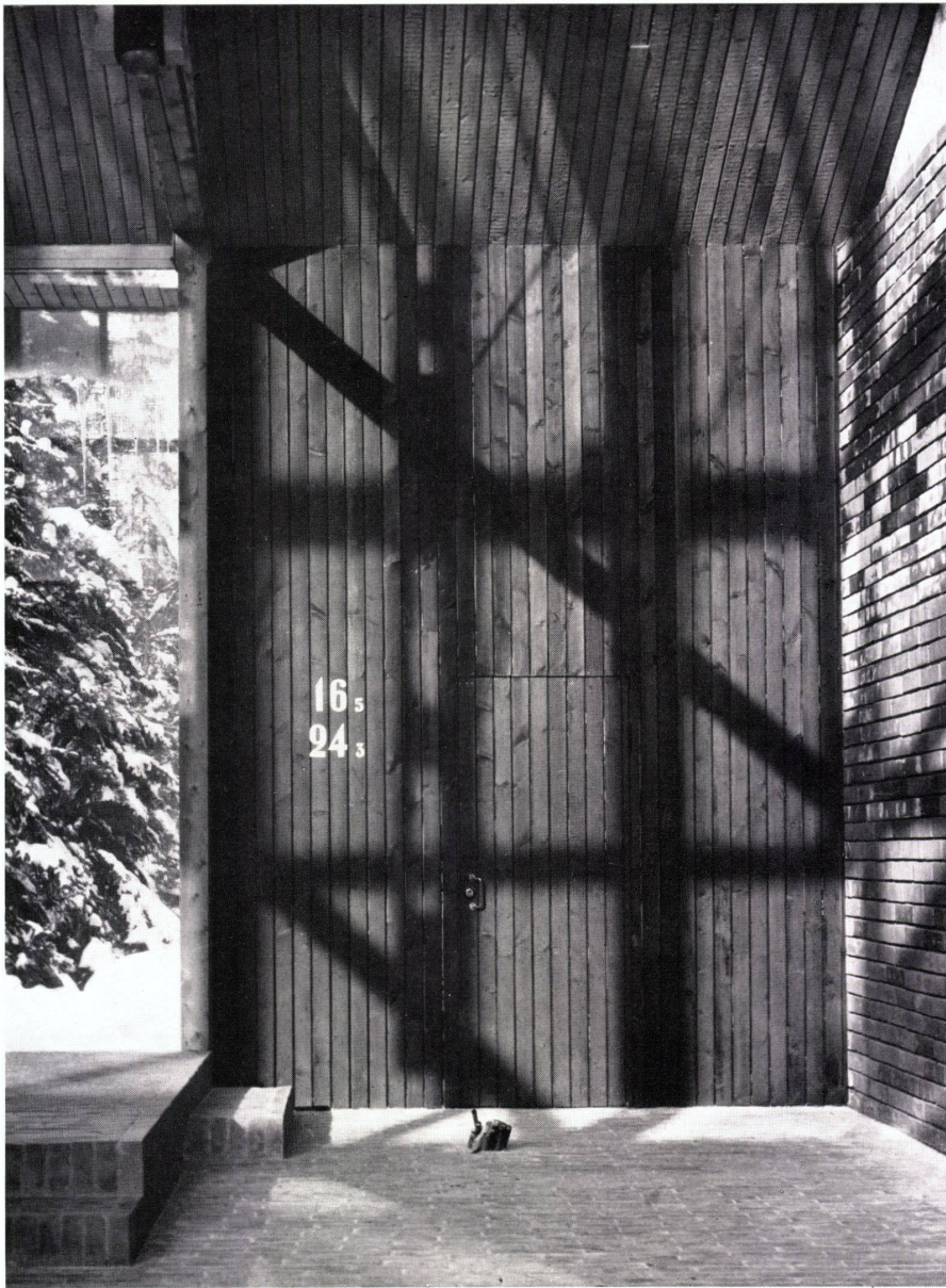
Türe zur Sakristei. Über dem Boden Rohrbündel für die Anschlußleitungen des Orgeltisches. Porte de la sacristie. Au niveau du sol, des faisceaux de conduites pour le branchement de l'orgue. Sacristy door. Above floor level ducts leading to organ.
