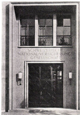
11 Suter und Burckhardt, Versicherungsgebäude in Basel, Haupteingang, 1941.
