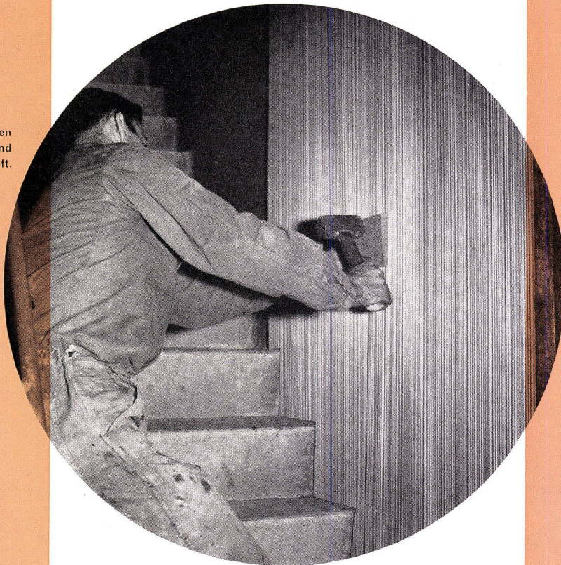
Fig. 2 Verlegen von Laril-Rillentäferplatten direkt auf Verputz
