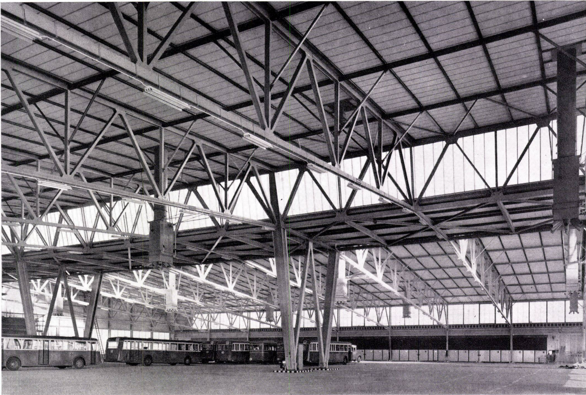
Trolleybusgarage VBZ Hagenholz, Zürich; Architekten SIA Casetti & Rohrer, Zürich
