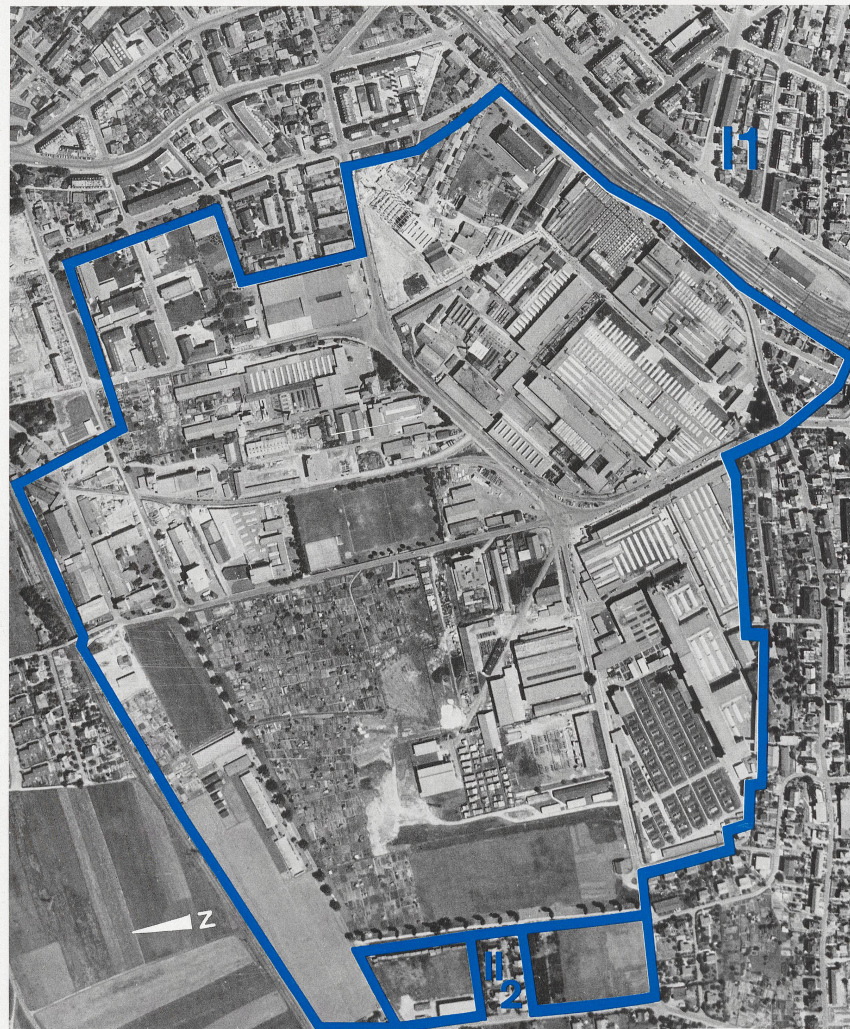
4 Flugbild der Industriezone I/1. Aufvallend für städtische Verhältnisse: relativ große Landreserven und großzügige orthogonale Anordnung der Gebäude. Vorwiegend Maschinenindustrie.
