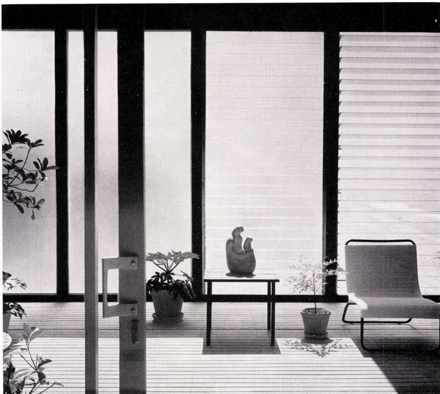
3 Seitlich geschlossener Balkon. Die äußere Verglasung ist undurchsichtig. Die Lüftung kann mit verstellbaren Glaslamellen reguliert werden. Terrasse fermée latéralement. Le vitrage extérieur n'est pas transparent. La ventilation peut être réglée au moyen de lames de verre orientables. Laterally closed terrace. The external glasswork is not transparent. Ventilation can be controlled by means of movable glass plates.
