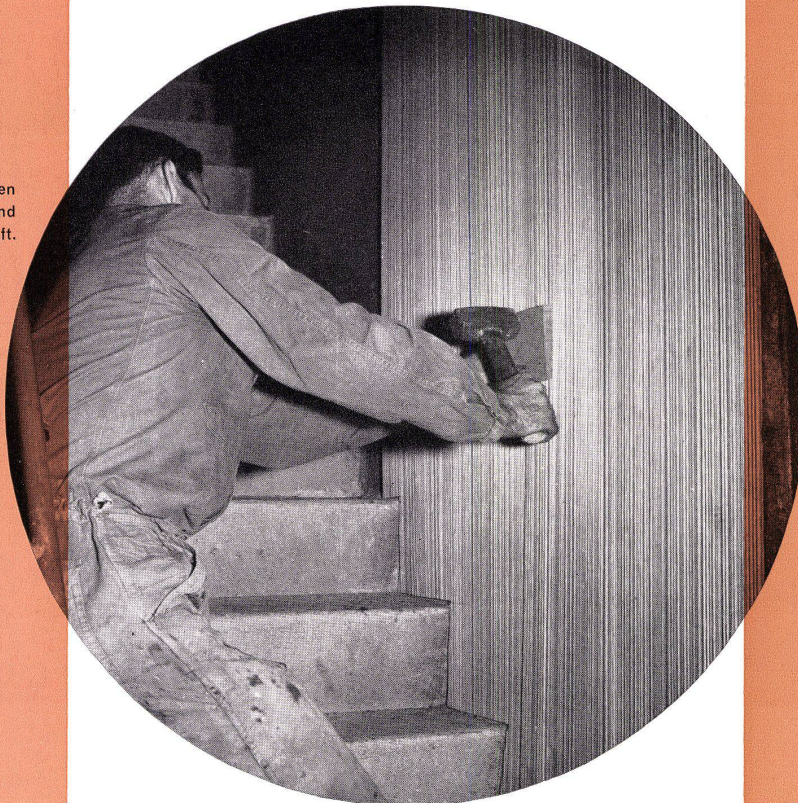
Fig. 2 Verlegen von Laril-Rillentäferplatten direkt auf Verputz
