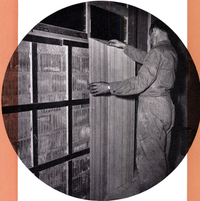
Fig. 1 Verlegen von Laril-Rillentäferplatten auf Lattenrost
