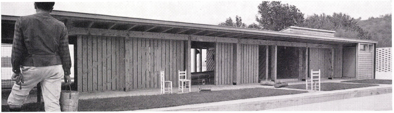
Fassade gegen die Landseite. Façade arrière. Rear elevation.
