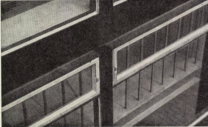
1 Isometrie der Fensterelemente im Erdgeschoß und im Obergeschoß und den Abdeckblechen vor den Stahlträgern.
