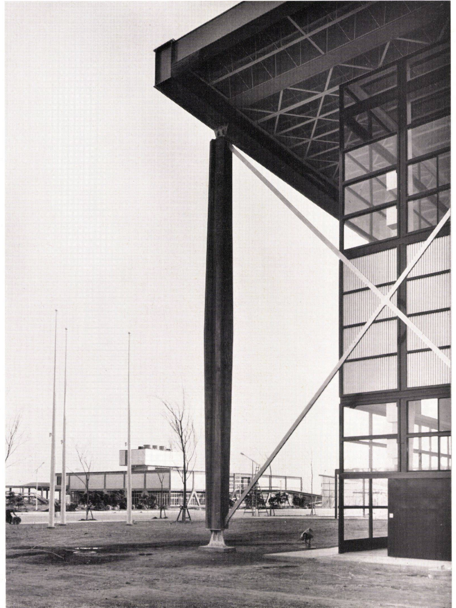
Vorfabrizierte Pendelsäule aus Stahlbeton der Halle 1. Im Hintergrund Halle 3. Colonne articulée préfabriquée en béton d'acier de la halle 1. Au fond halle 3. Prefabricated column with ball and socket seating of steel concrete of hall 1. In the background hall 3.
