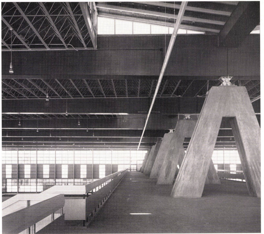
Betonsäule zur Aufnahme der Stahlträger in der Halle 1. Pilier de béton supportant le sommier d'acier dans la halle 1. Concrete pillar to receive steel girder in hall 1.
