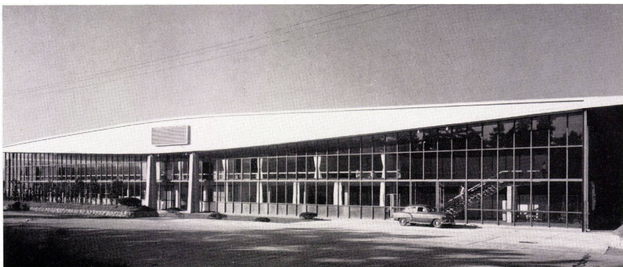
39 Stirnfassade der Druckerei in Numazu. Élévation de front de l'imprimerie à Numazu. Front elevation of the printing shop in Numazu.
