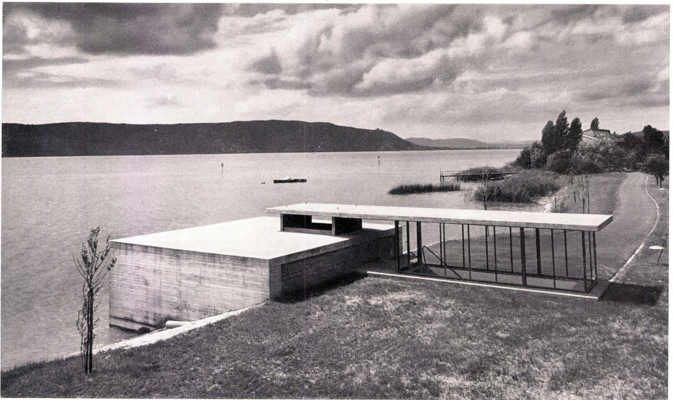
Das Entlastungsbauwerk mit Ausgang des Fußgängerstollens. Blick auf Überlinger See, Bodanrück und Hegau. Le bâtiment de décharge avec sortie de la galerie des piétons; vue sur le lac d'Ueberlingen, Bodanrück et Hegau. Discharge building and the exit to the pedestrians' gallery, looking onto the Lake of Ueberlingen, Bodanrück and Hegau.
