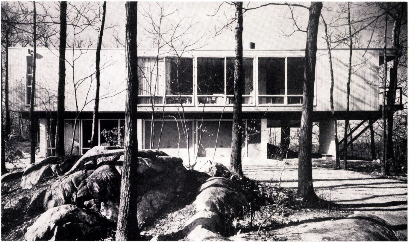
Nordfassade mit Zufahrt, Garagen und Eingang. Façade nord et accès, garage et entrée. North elevation and access, garage and entrance.
