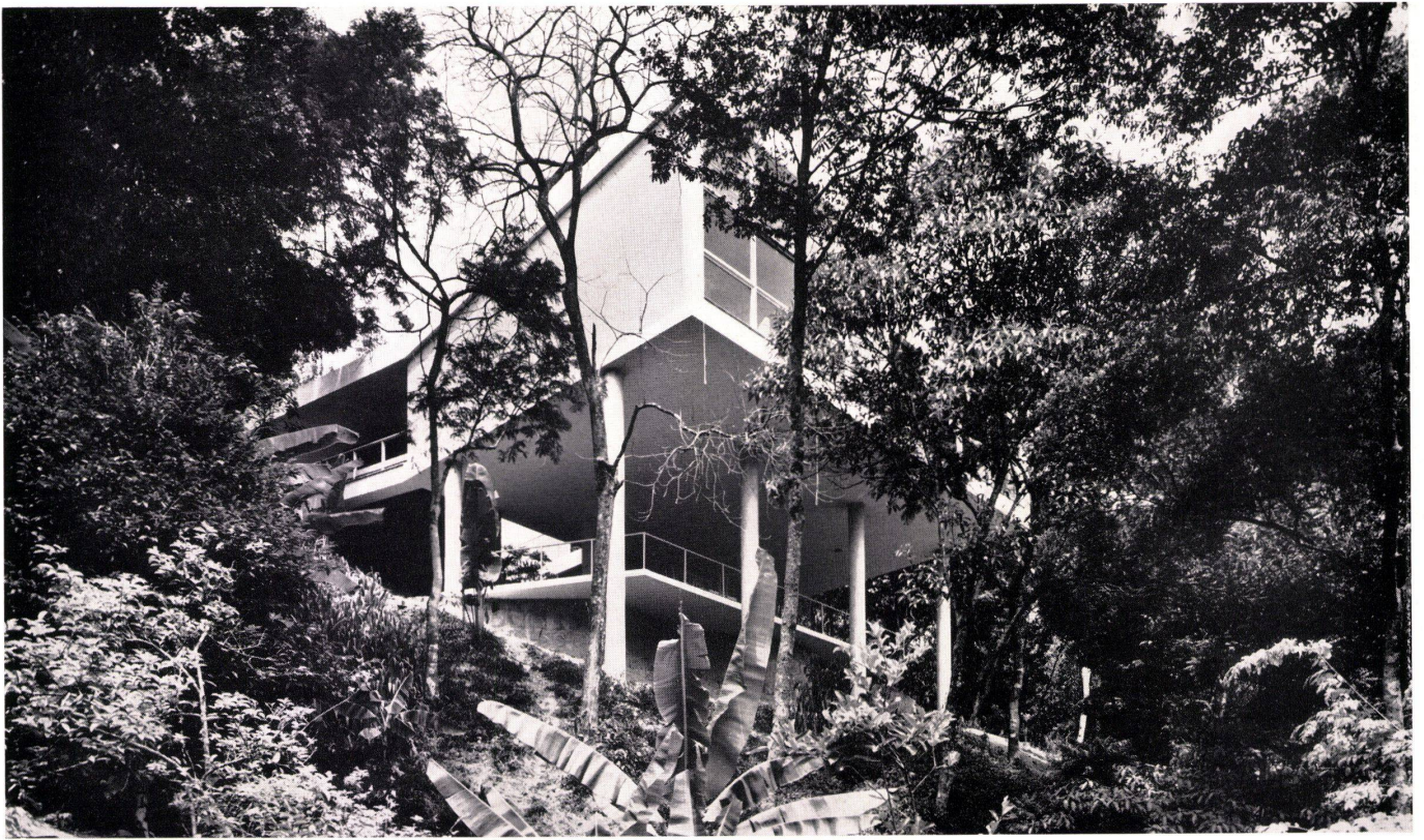
Westansicht des Wohnteils. Unter dem Baukörper mit dem Wohnraum befindet sich ein gedeckter Sitzplatz. Vue ouest de l'aile d'habitation de la villa. Sous l'aile séjour, terrasse couverte. View from the west of the living-quarters. There is a covered seating-area under that part of the house containing the lounge.
