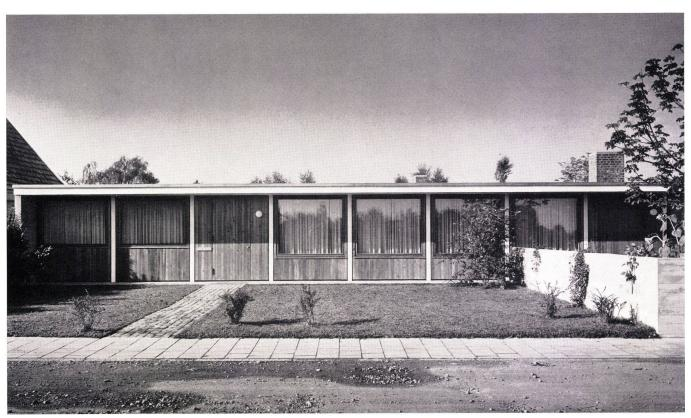
oder niederen Brüstungen, Vollwand-, Türenoder Torelementen) wurden so konstruiert und eingebaut, daß sie jederzeit wegmontiert und in ein anderes Stützenfeld eingesetzt werden können - gleich wie die Innenwandelemente. So läßt sich also die Fassade verändern, daß sie einem veränderten Innern entspricht.
