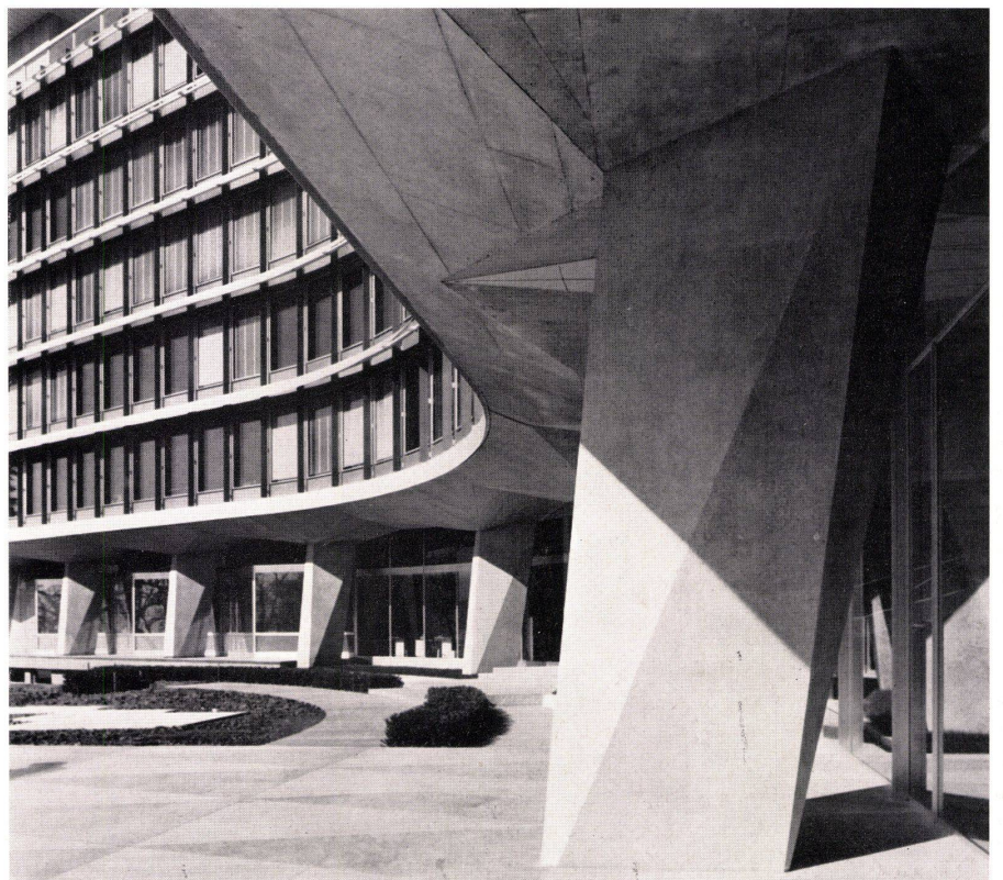
Ausschnitt des Betontisches auf der Nordseite, auf den die Stahlkonstruktion der sechs Obergeschoße abgestellt ist. Partie de la table de béton, sur le côté nord, sur laquelle sont posés les 6 étages de construction métallique. Detail of concrete table on north side, on which rests the steel construction of the six floors.
