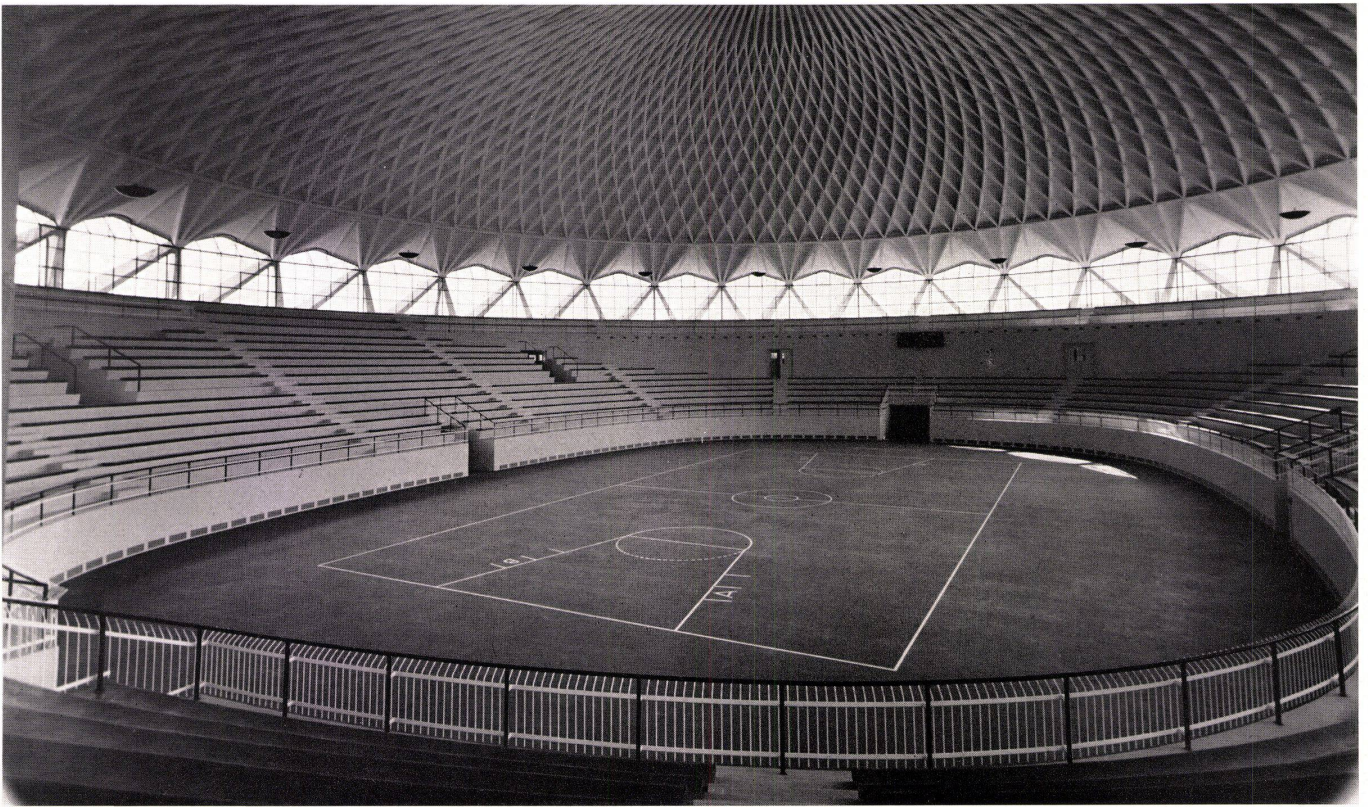
5 Untersicht der Kuppel 1:900. La coupole vue du dessous. The dome viewed from below.
