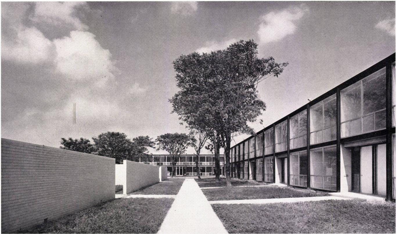
1 Ein Fußgängerweg, der links zu den Gartenhöfen vor den 1geschossigen Einfamilienhäusern und rechts zu den 2geschossigen Bauten mit den Maisonnettewohnungen führt.
