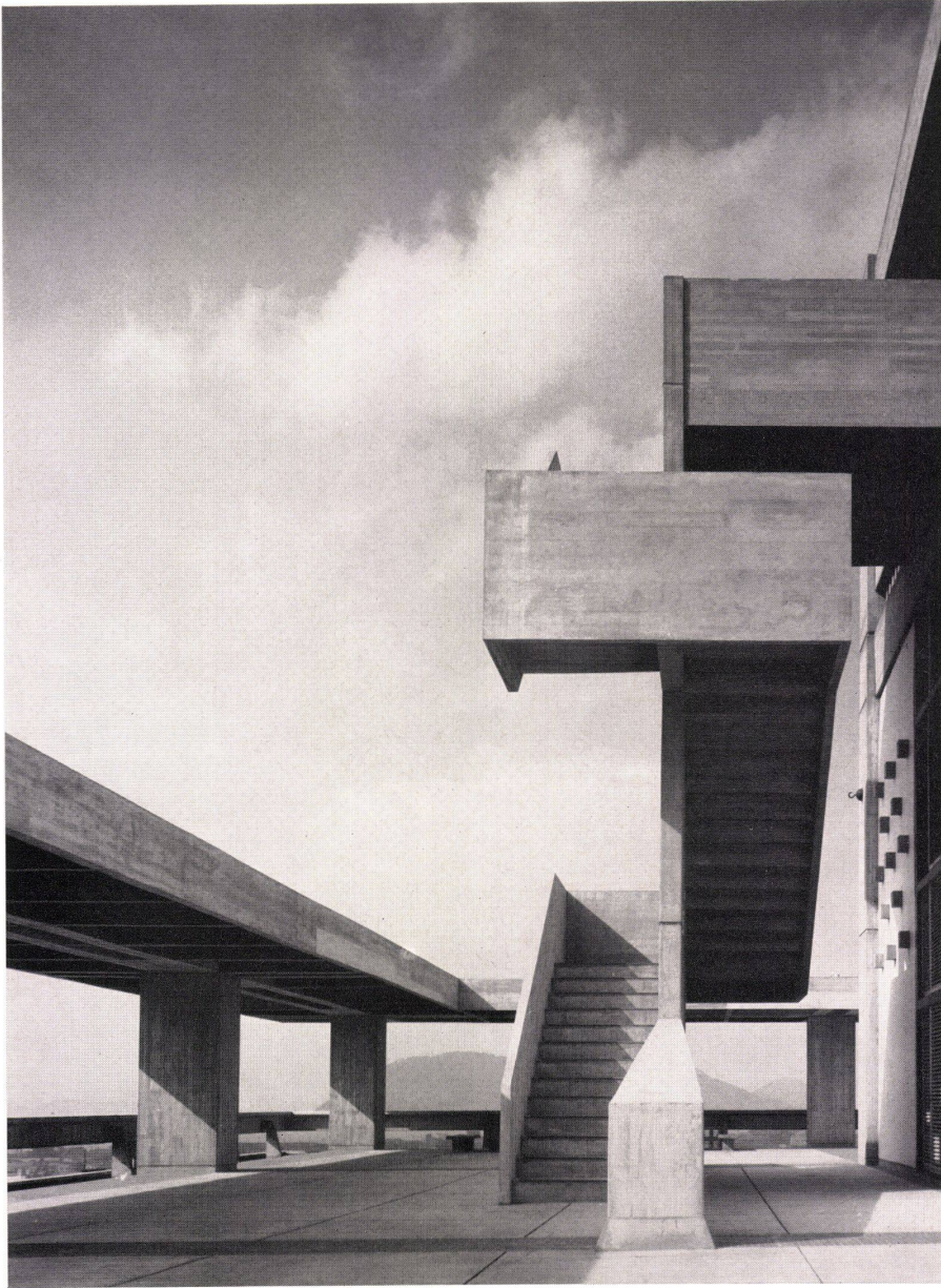
1 Dachaufbau auf dem Hauptgebäude. Die Treppe führt zum Aussichtsplattform.
