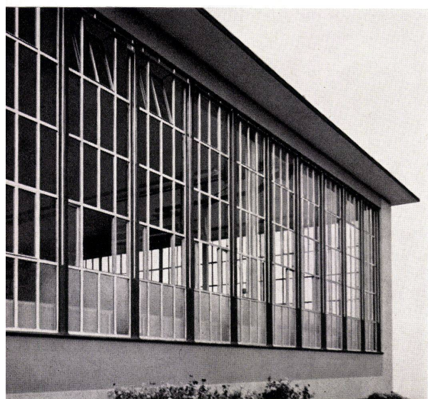
ALSEC-Leichtmetallprofile K = 2,25 - 2,5 Isolierglas-Elemente K = 2,5 - 3,0
