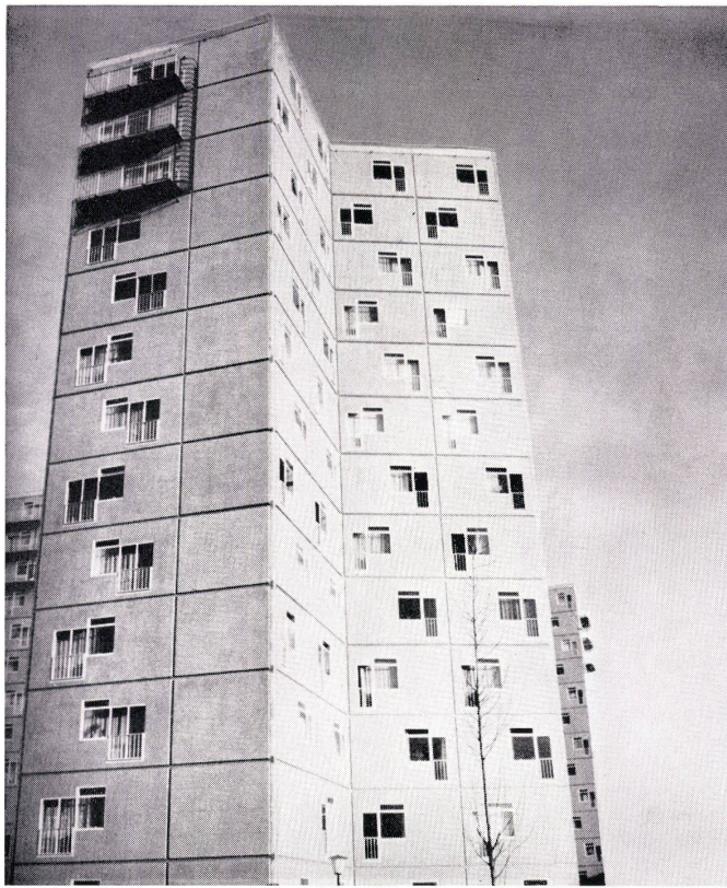
Wohnhochhaus mit vorfabrizierten Außenwandelementen (französisches Beispiel).
