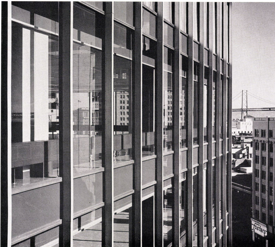
3 Ausschnitt einer Fassade. Das Profil der stehenden Aluminiumsprossen ist außerordentlich schlank. Partie de façade. Les profils verticaux des fenêtres en aluminium sont extrêmement minces. Detail of an elevation. The profile of the vertical aluminium mullions is extraordinarily slender.
