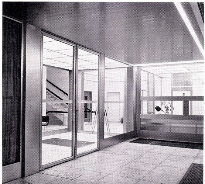
Eingangspartie mit Vordach. Vordachuntersicht mit Wandverkleidungsprofilen.
