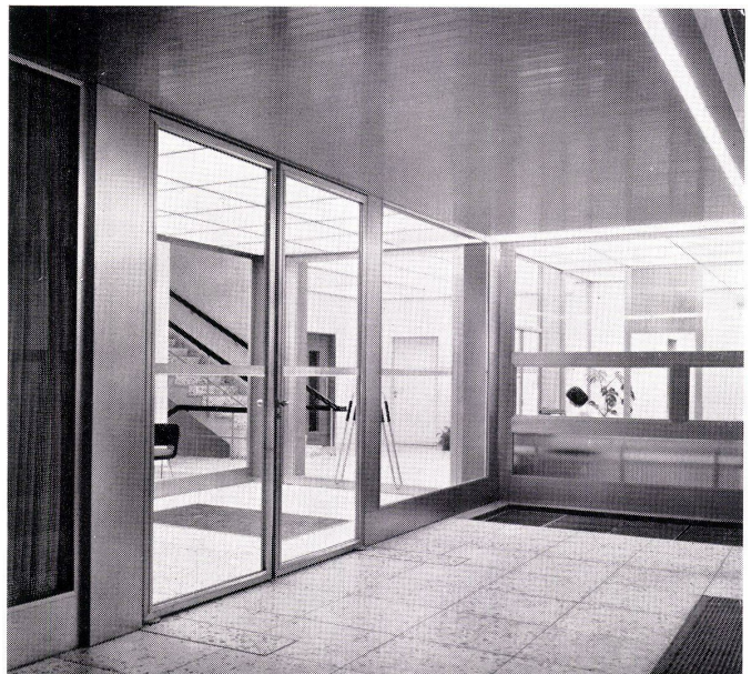
Eingangspartie mit Vordach. Vordachuntersicht mit Wandverkleidungsprofilen.
